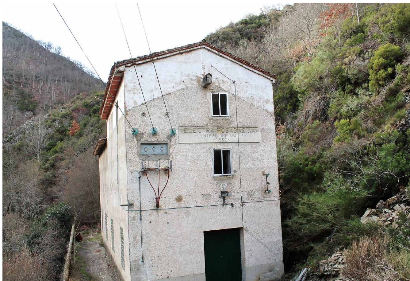
Vista general de la casa de máquinas de la Central del Águila
