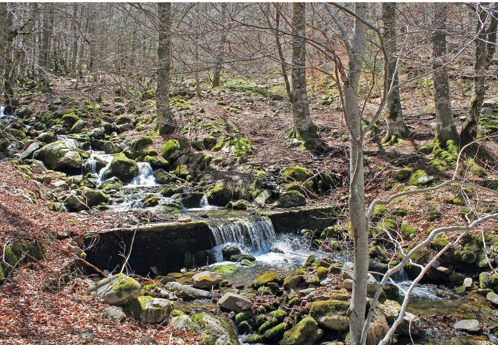
Muro-presa construido para desviar las aguas del río La Llanada
