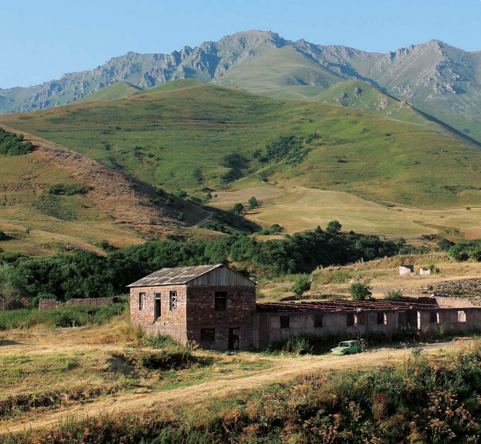
Ruinas de una granja colectiva en las faldas del monte Aramazd (3399 m).
