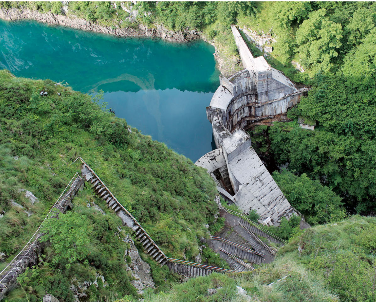
Presa de La Jocica desde lo alto de la escalera de servicio.
