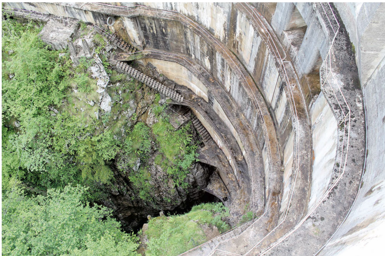
Detalle del muro interior de la presa de La Jocica.
