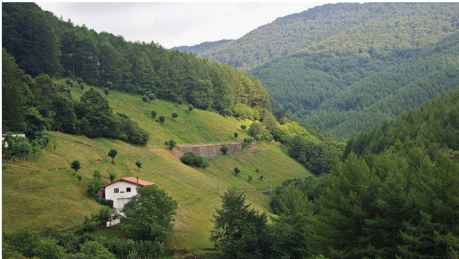
Buscando divisoria, el trazado gana metros por la vertiente de Erasote, sostenido por un muro de contención.
