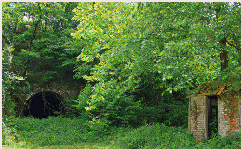
Restos de la estación de Plazaola y el túnel hundido de Olaso
