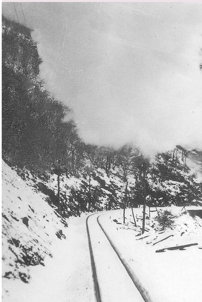
Humo del ferrocarril en el Túnel de Barrenola ARCHIVO MUSEO VASCO DEL FERROCARRIL
