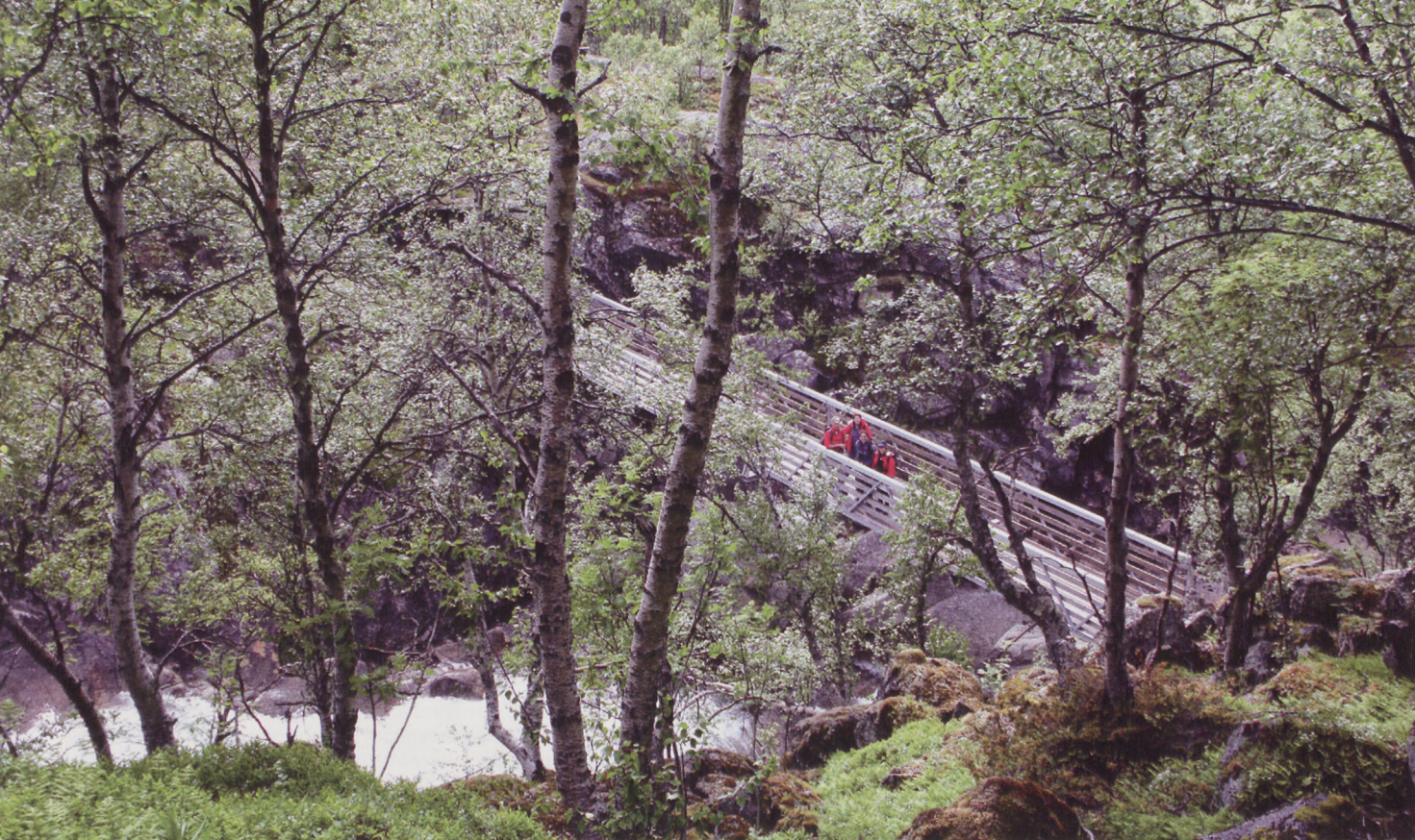
■ Puente peatonal en el camino de los Navvies
