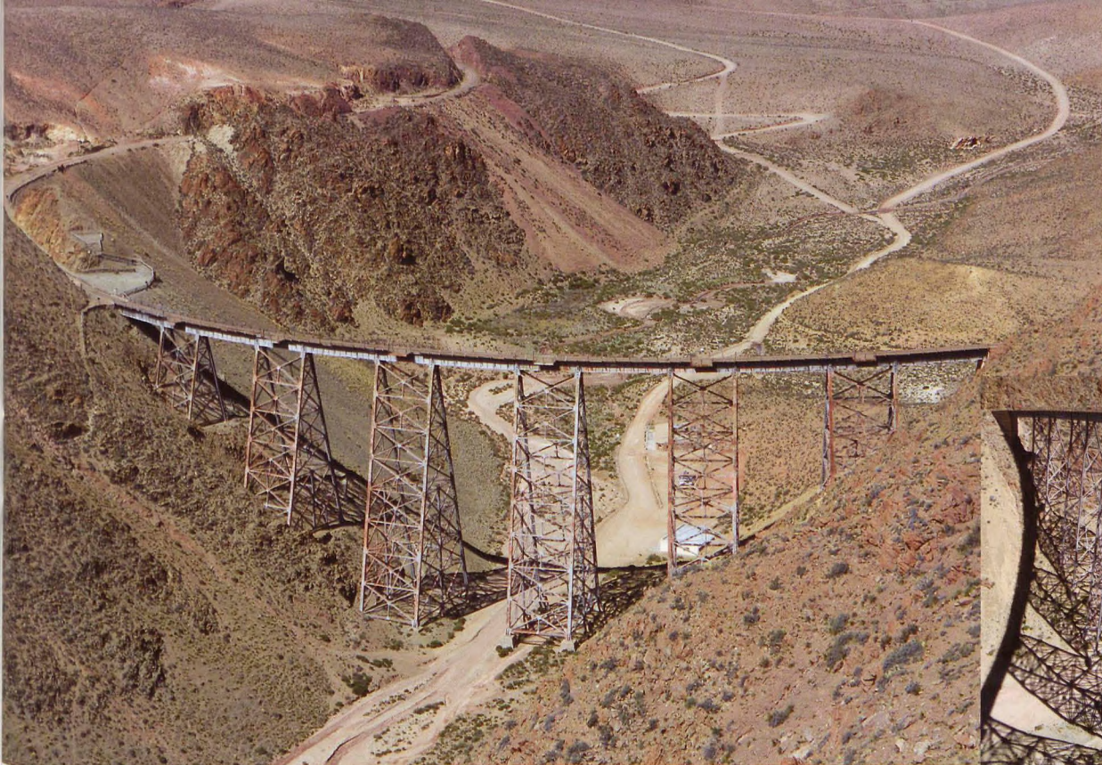
■ Viaducto La Polvorilla
