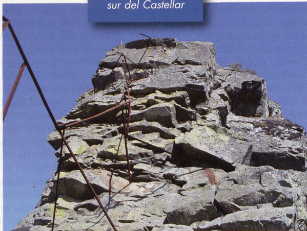
Restos de anclajes metálicos en la peña sur del Castellar
