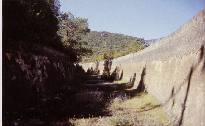
■ Canal de Fontecha
