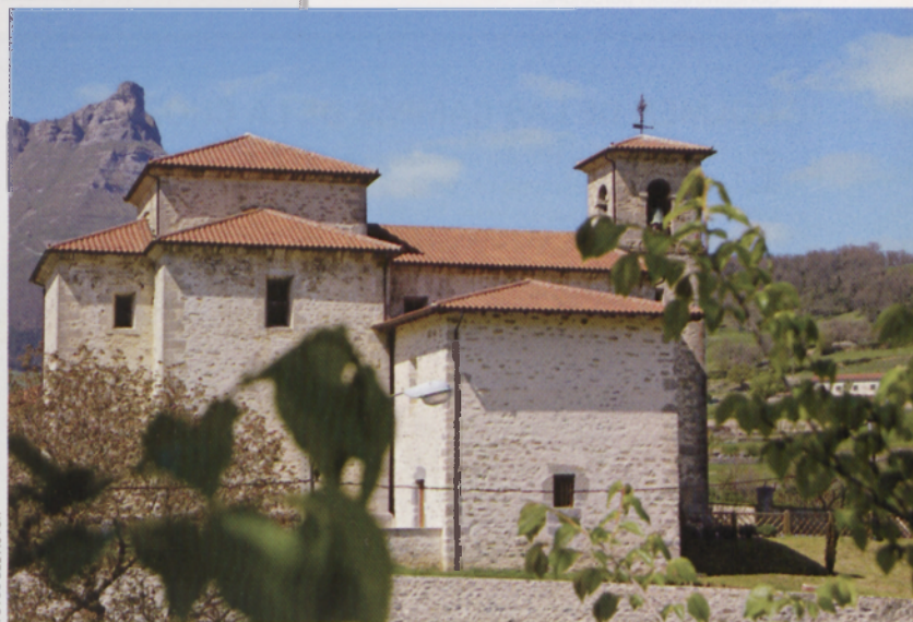
■ Casa Torre de Lendoño de Abajo
