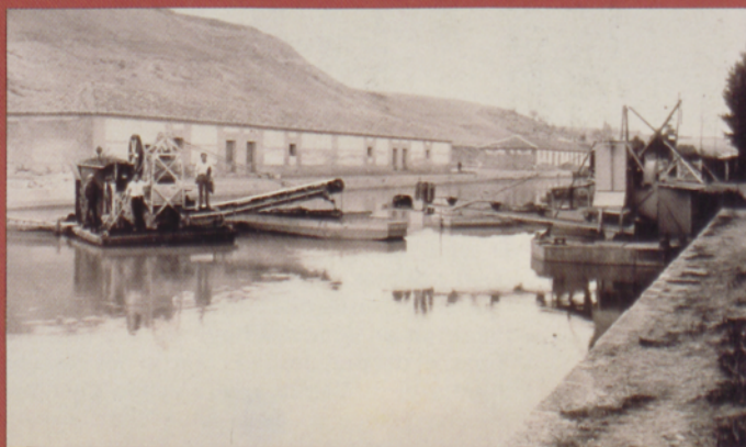
■ Batea en la dársena de Valladolid. Ramal del Sur
