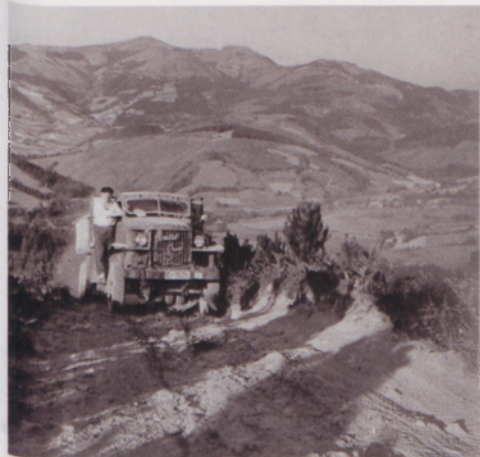
■ El transporte del material a pie de obra fue muy dificultoso
