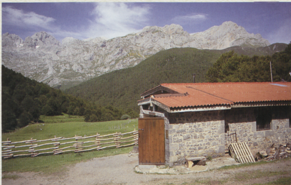
■ Refugio de Vegabaño, con Peñasanta de Castilla y Torre Bermeja
