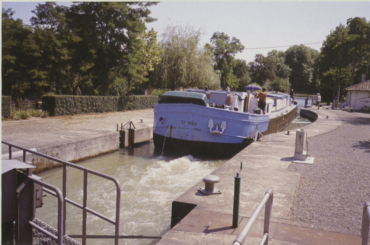
■ Ver el funcionamiento de las primeras esclusas del canal supone un espectáculo
