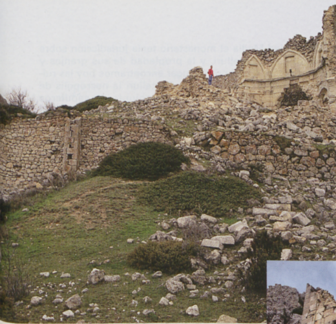
■ Muros de base en la parte que mira a La Rioja
