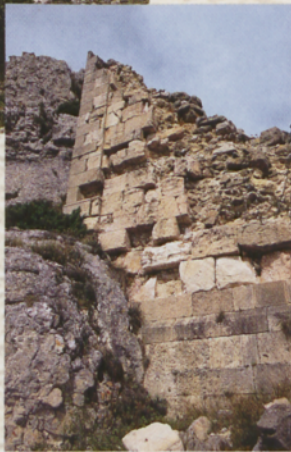
■ Detalle del apoyo de las paredes sobre la roca natural
