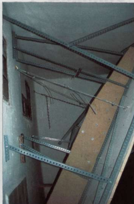
Estructura de refuerzo con perfiles de estantería y sirga de seguridad
