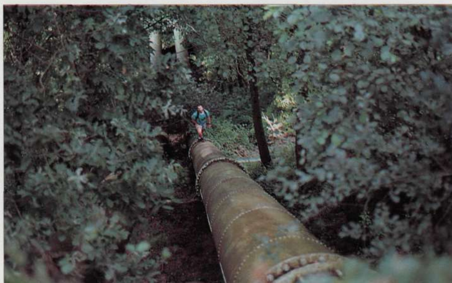
Superado el sifón de Costalada por la tubería remachada
