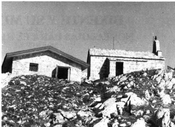
El refugio y la ermita de Aitzkorri. Un conjunto reconstruido que ha sido inaugurado en setiembre.
