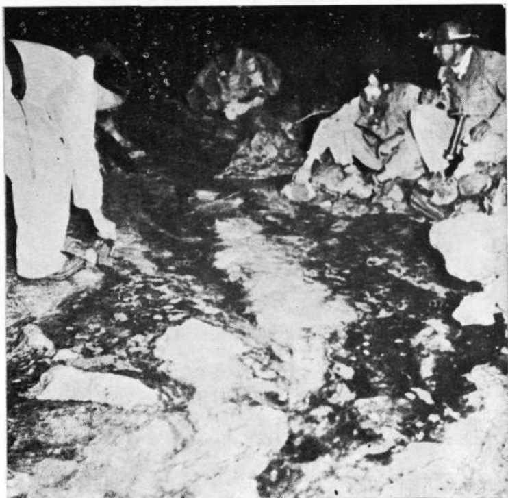
Miembros del equipo «A» realizando la experiencia de coloración de aguas.
