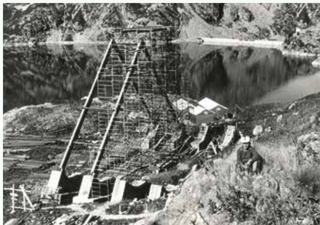
Refugio de Piedrafita en construcción (Archivo EMF)
