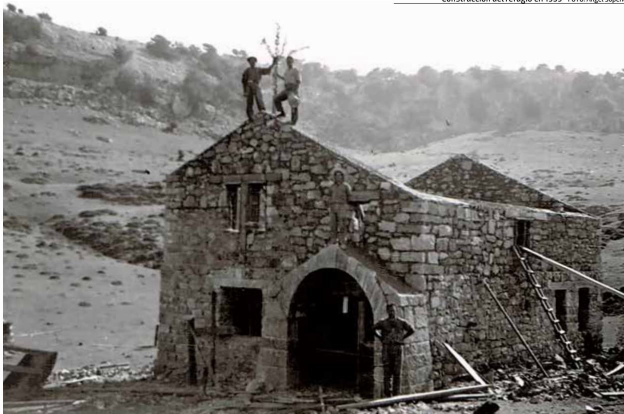
Construcción del refugio en 1959 - FOTO: Ángel Sopena
