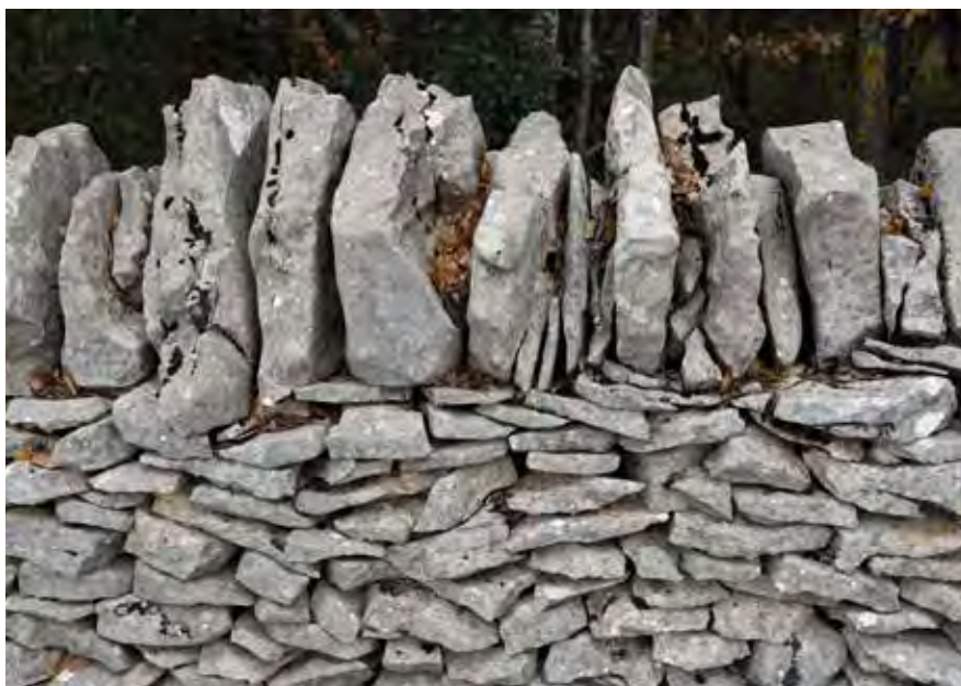
Muro de piedra seca
