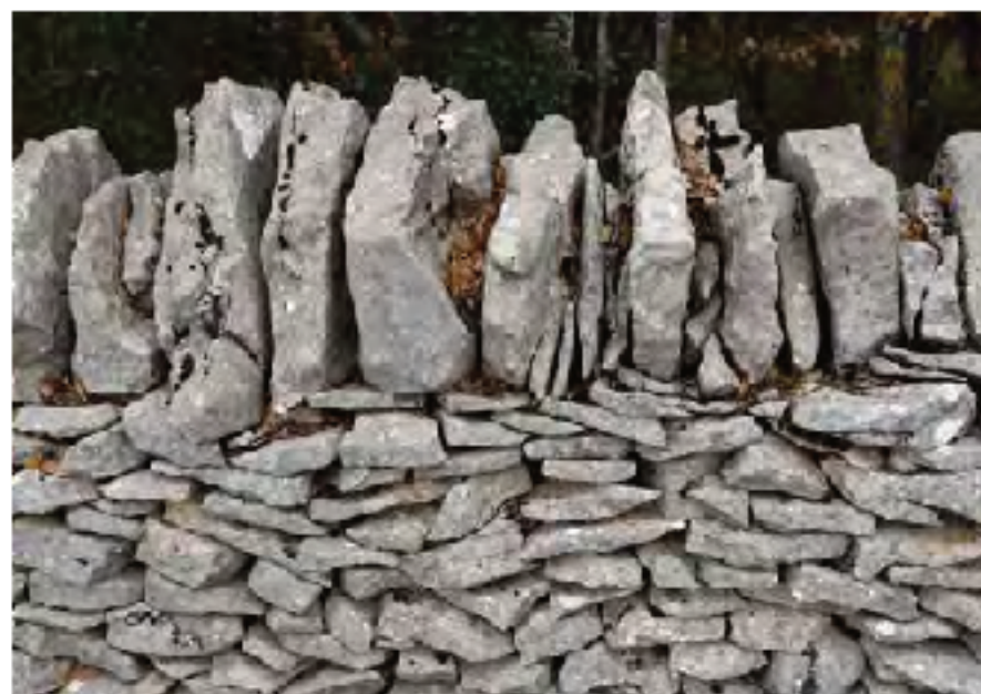
Muro de piedra seca
