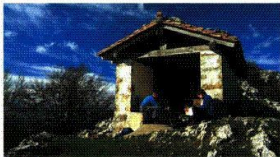
■ La ermita de Santikurtz, modesto edificio erigido sobre la cresta de la montaña, aparece citada ya en el S. XVI
