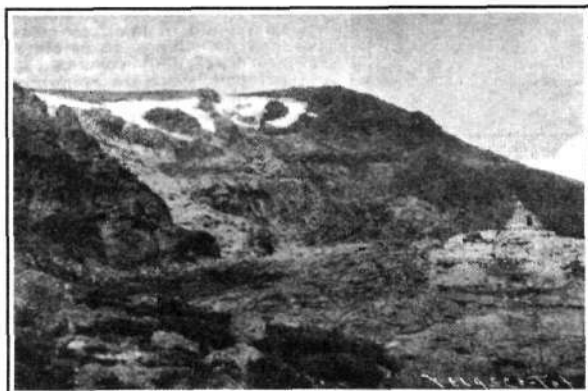
.....llegamos al Refugio Zabala. Es una construcción sencilla y práctica, totalmente de alta montaña.
